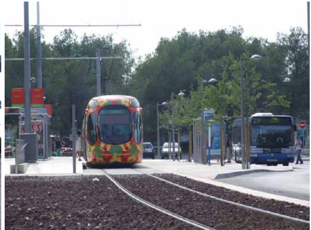
Citadis 30m ligne 2 et Agora Line de la ligne 22 au terminus Jacou
