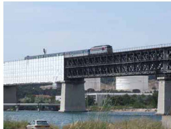
67300 multisevices tracte une RRR sur le pont métallique
