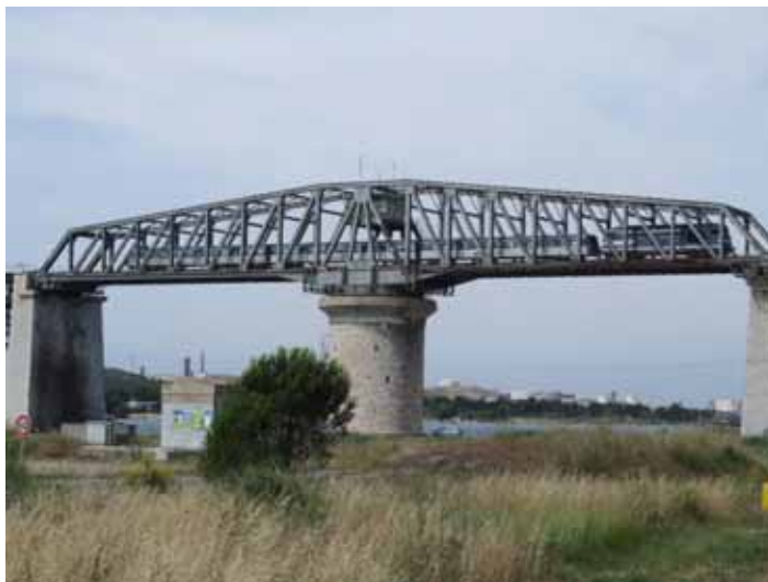
67300 tracte une RRR sur le pont mobile de Martigues
