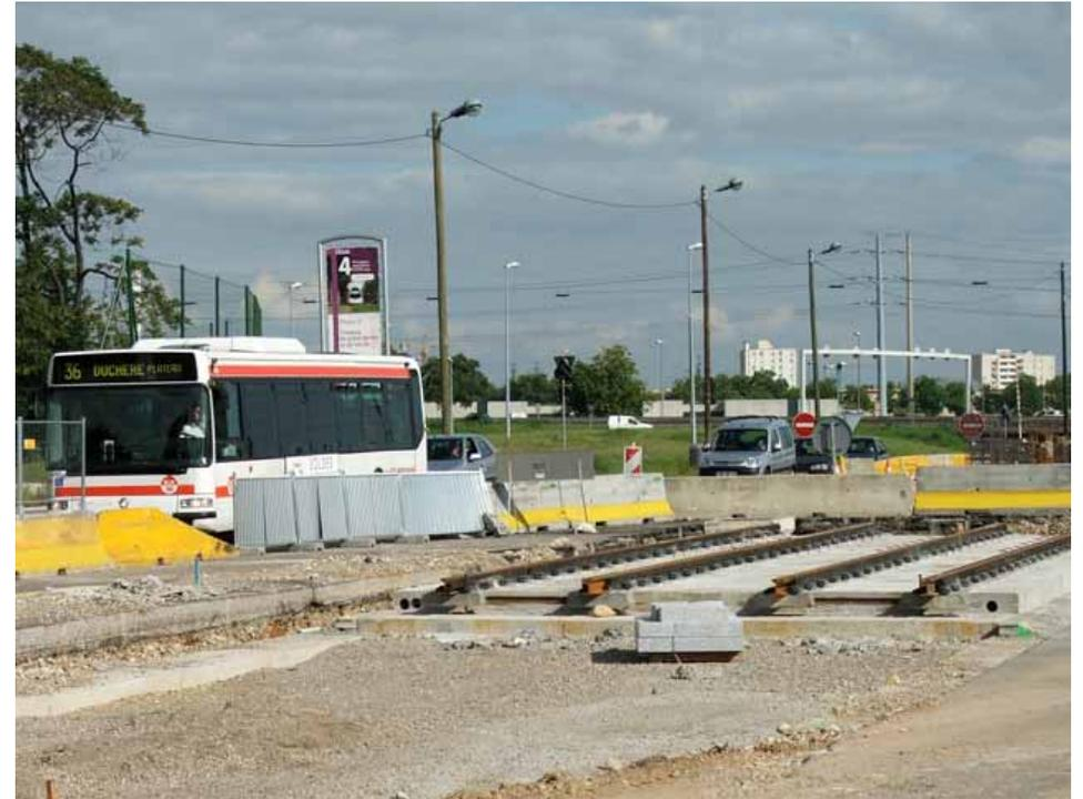
Après les finitions de plateforme et la pose de la multitubulaire, les travaux s'attaquent désormais à la pose des voies dans le secteur Etats-Unis / Viviani / Curie. Les rails sont semble-t-il posés en priorité dans les carrefours, pour être rapidement rendus à la circulation la rentrée de septembre arrivée. Pendant les périodes de forte affluence de la rentrée, les équipes pourront alors s'occuper plus tranquillement de la pose des rails en section courante.
