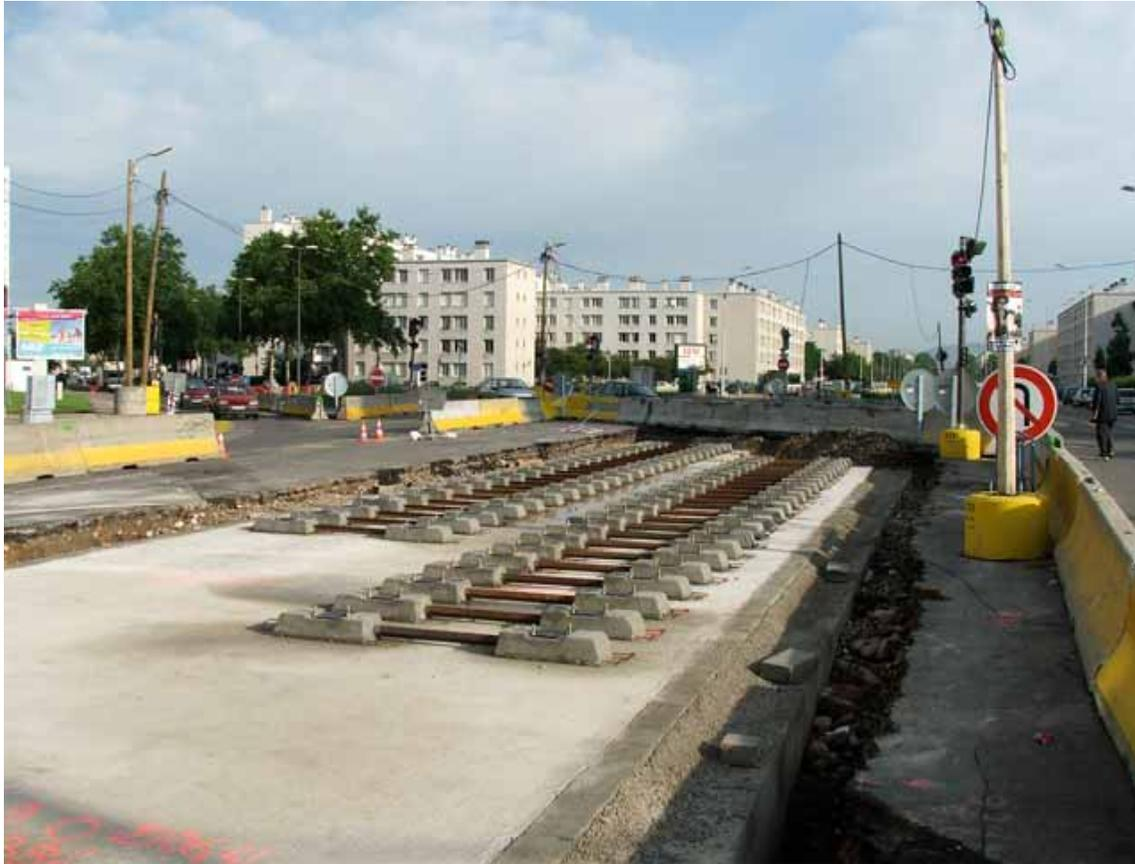
A la limite entre Vénissieux et Lyon 8, les travaux de T4 battent leur plein. Plateforme béton, massifs de poteaux de LAC et pose de quelques traverses ont marqué ce mois de juin 2007.
