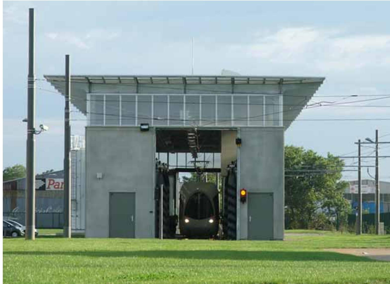
Comme à St Priest, les rames qui sortent de la ligne T3 pour entrer au dépôt passent par le tunnel de lavage, qui comprend les rouleaux de nettoyage extérieur, l'aspirateur et le plein de sable. Une chose à noter, le centre de maintenance de Meyzieu est classé en « HQE » pour Haute Qualité Environnementale.
