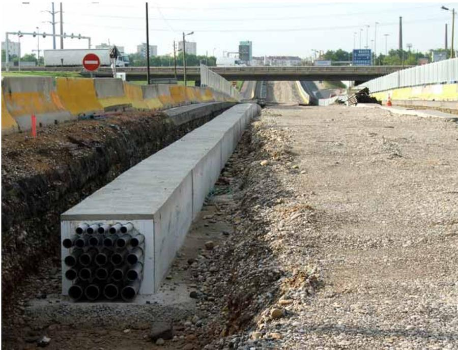
Sous le périphérique L. Bonneval, c'est la multitubulaire qui est en cours de pose sur les bords de la future plateforme. Elle permet l'acheminement le long des voies des courants forts, courants faibles, ainsi que de nombreuses communications servant à la billettique, à la coordination des carrefours à feux ou encore à la vidéosurveillance.
