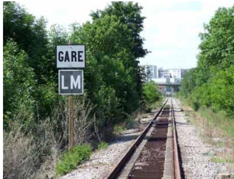
Les voies sont posées sur des traverses bi-blocs en béton.
