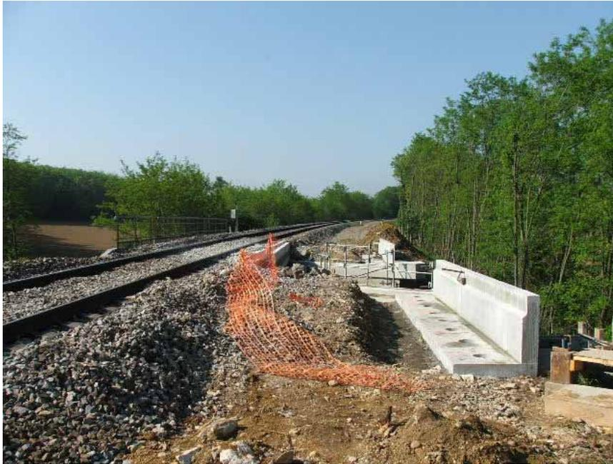
Dans le cadre d'une modernisation de la ligne, qui va permettre une amélioration des fréquences des trains ainsi que de leur régularité, RFF s'active actuellement au doublement de la voie entre la gare des Echets et celle de Villard les Dombes, dans l'Ain. Ces travaux, outre la pose d'une seconde voie, consistent à terrasser, à poser plusieurs nouveaux ouvrages, comme le doublement de ponts (voir photo ci-contre aux Echets) ou encore la modification de la signalisation.
