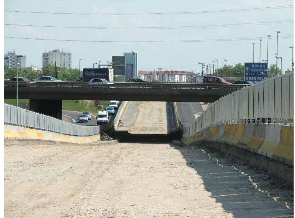
Du côté de T4, les travaux de plateforme avancent bien. Désormais, tous les éléments du terre plein central ont été évacués (éclairage public, panneaux de signalisation, glissières métalliques...), pour laisser place à une tranchée d'une profondeur de 50 cm environ. Les travaux les plus avancés sont visibles entre « Etats-Unis – Viviani » et « Carrefour Sembat Curie ».
