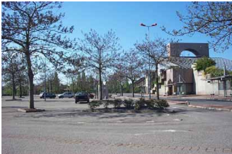
L'ancien parc relais, avant les travaux
