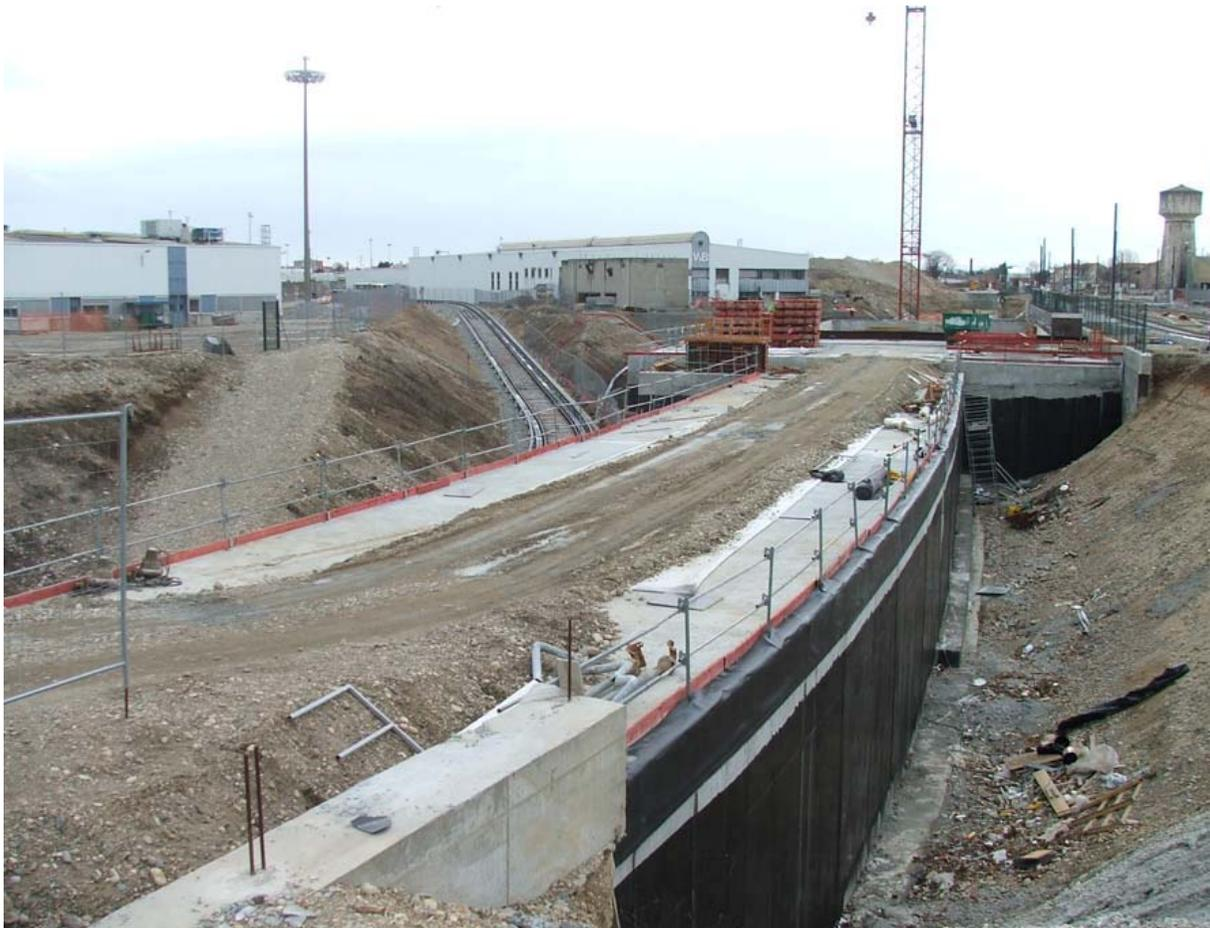
On peut désormais bien discerner l'emplacement de la future station de métro A « Vaulx - Carré de Soie ». Au 1er plan, le coffrage dans lequel circuleront les rames. A l'arrière la station rectangulaire en cours de fermeture.
