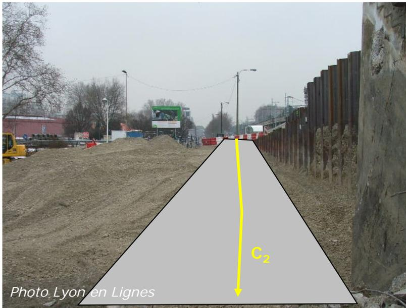
Plus au Sud,  $C_2$  se glissera contre la rampe du Pont Poincaré, qui est pour le moment renforcé par des palplanches.
