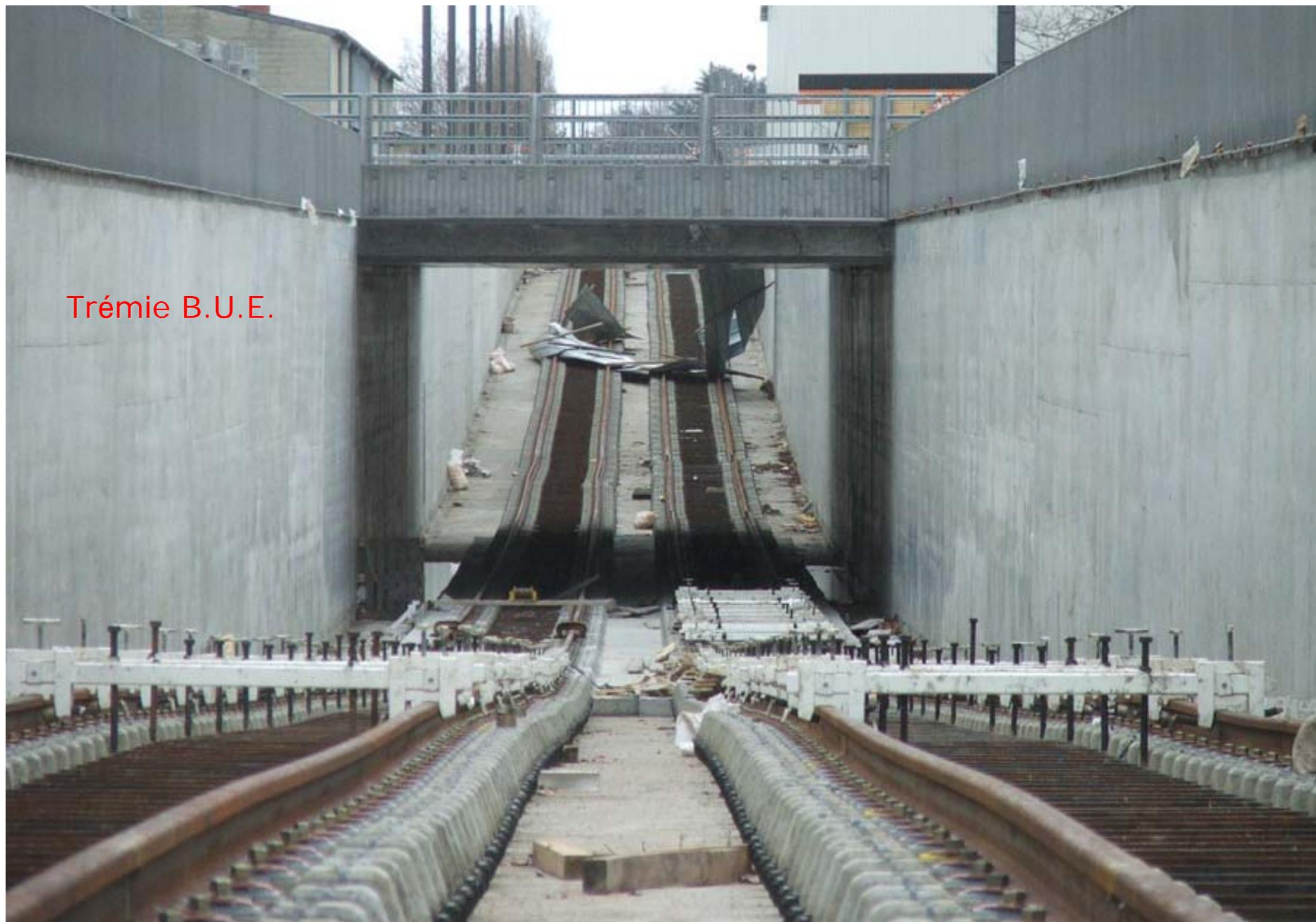
Les rails sont enfin en cours de pose sous la trémie du futur B.U.E qui passera dans quelques années au dessus de LEA. Au regard de l'importance de ce futur axe routier, une trémie a été préférée à un carrefour classique.
