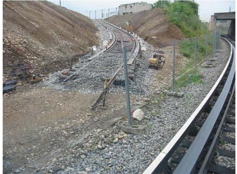
Construction de la nouvelle voie d'accès aux ateliers : préparation avant la pose du nouvel aiguillage.
