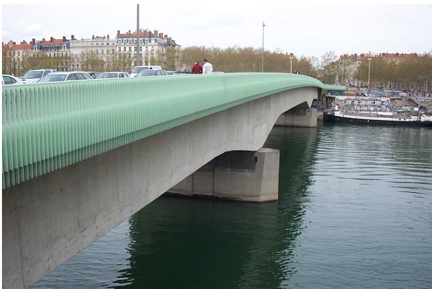
Ci-contre, le métro A de Lyon franchi le Rhône à l'intérieur du tablier du Pont Morand entre la Place M. Lyautey et l'Hôtel de Ville. Le pont a dû être spécialement reconstruit pour le passage du métro en 1978.
