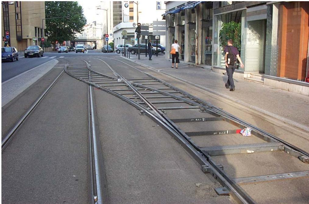
Ci-dessus, le "californien" qui permet au tramway de se retourner au sud de Charpennes, sans toutefois engager les grands frais occasionnés par la pause d'un aiguillage classique. Cette solution temporaire va permettre une exploitation au maximum de la ligne disponible.
