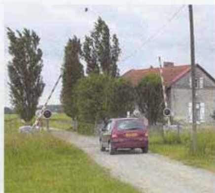
④ ...quand le train est passé les demi-barrières se relèvent. Le passage est ouvert seulement quand le feu rouge s'éteint.
